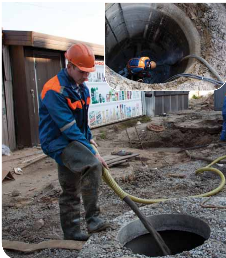
На фото: откачка воды из колодца для врезки в коллектор водоснабжения бригадой горводоканала с помощью МПБ-600
