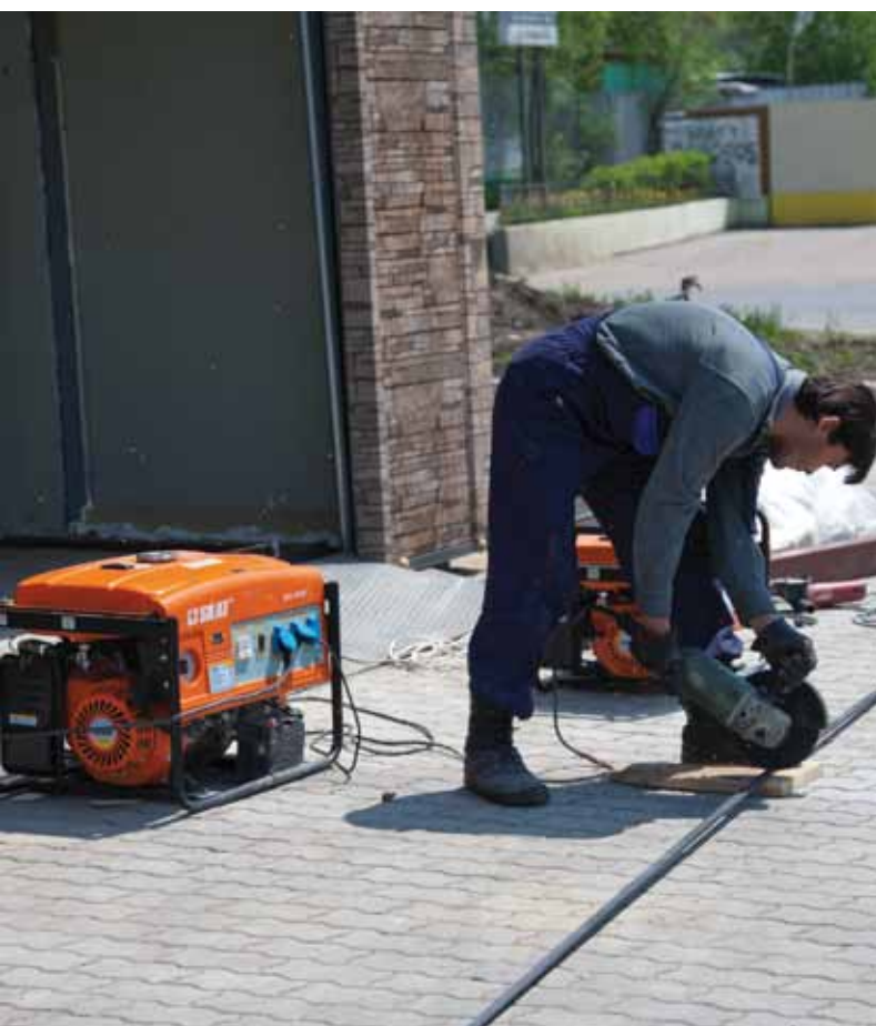
На фото: строительство автомоечного комплекса с помощью УГБ-4000Е и УГБ-2300 (подключение инверторных сварочных аппаратов и электроинструмента)
